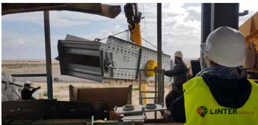
Projekt wymiany przesiewacza o wydajności 300 t/h do instalacji fosforytów - OCP SA, Maroko
