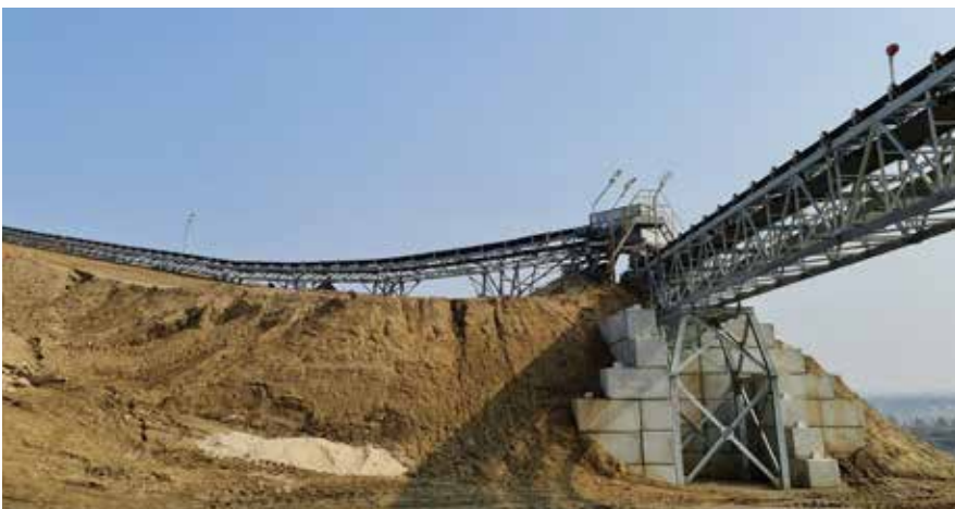
Przebudowa układu transportu odpadów poflotacyjnych na stawach osadowych ZGH Bolesław
