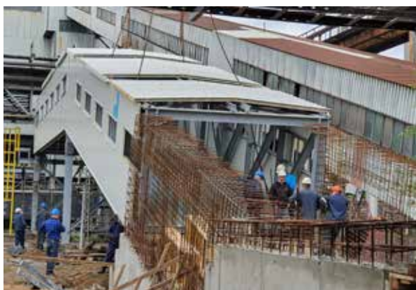
Budowa mostu przenośnikowego KWK Chwałowice
