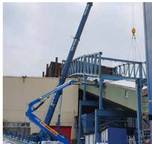
Wymiana mostu przenośnikowego odstawy surowej rudy żelaza - LKAB, Szwecja
