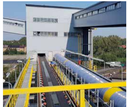
Budowa odstawy taśmowej kamienia ze zbiornikiem magazynowym i stacją załadowczą z możliwością załadunku na samochody - KWK Janina
