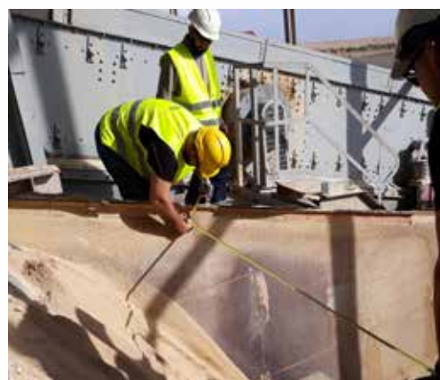
Projekt wymiany przesiewacza o wydajności 300 t/h do instalacji fosforytów - OCP SA, Maroko
