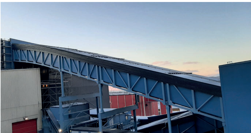
Wymiana mostu przenośnikowego odstawy surowej rudy żelaza - LKAB, Szwecja
