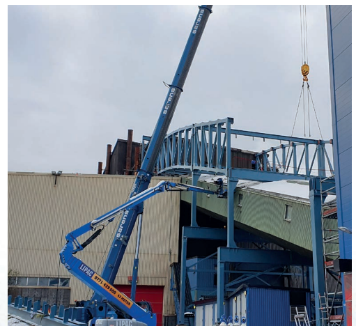
Wymiana mostu przenośnikowego odstawy surowej rudy żelaza - LKAB, Szwecja
