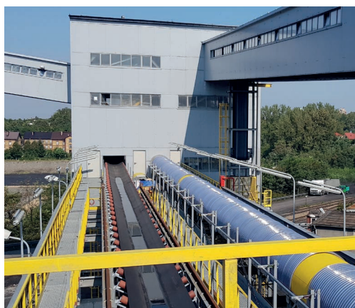
Budowa odstawy taśmowej kamienia ze zbiornikiem magazynowym i stacją załadowniczą z możliwością załadunku na samochody - KWK Janina
