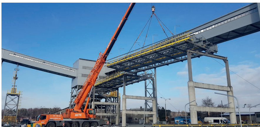
Budowa odstawy taśmowej kamienia ze zbiornikiem magazynowym i stacją załadowniczą z możliwością załadunku na samochody - KWK Janina
