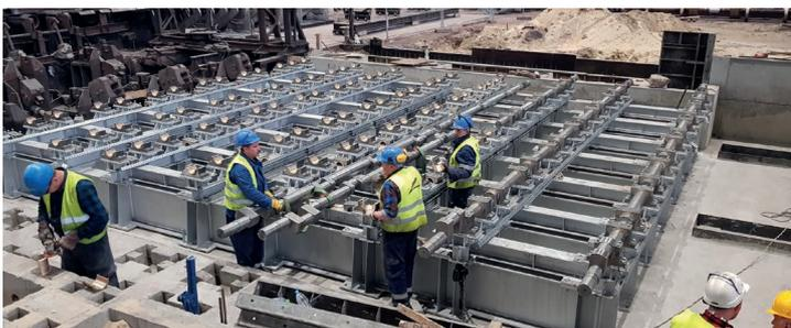
Bau einer Abkühlungsstrecke für Stahlelemente, **Hüttenwerk Stalowa Wola**
