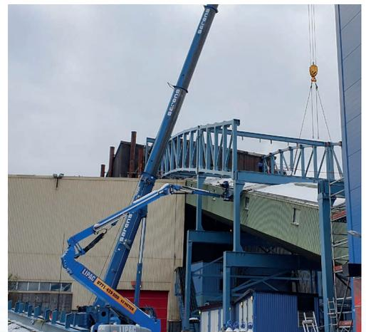
Ersatz einer Förderbandbrücke für den Transport von Roheisenerz, LKAB, **Schweden**
