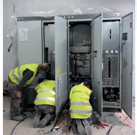
Austausch von Asynchronmotoren und der dazugehörigen Komponenten.
