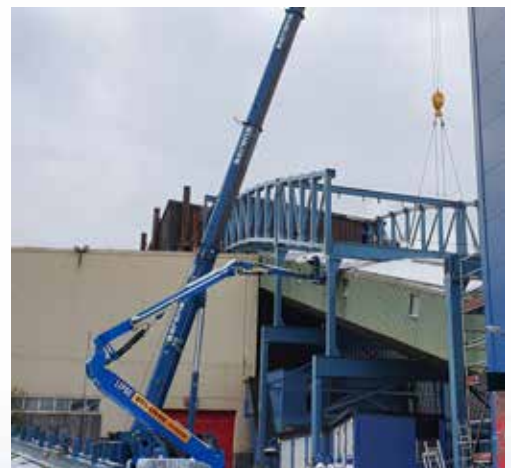
Échange de pont roulant pour le transport de minerai de fer-LKAB, Suède
