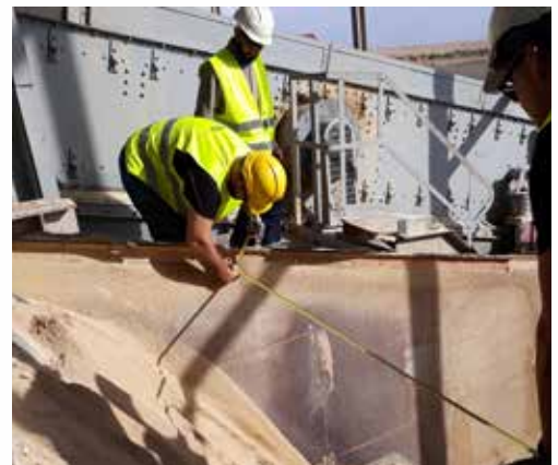
Projet d'échange du crible vibrant d'une capacité de 300 tons/h pour l'installation de phosphates – OCP SA, Maroc
