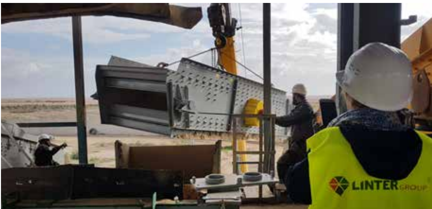
Projet d'échange du crible vibrant d'une capacité de 300 tons/h pour l'installation de phosphates – OCP SA, Maroc
