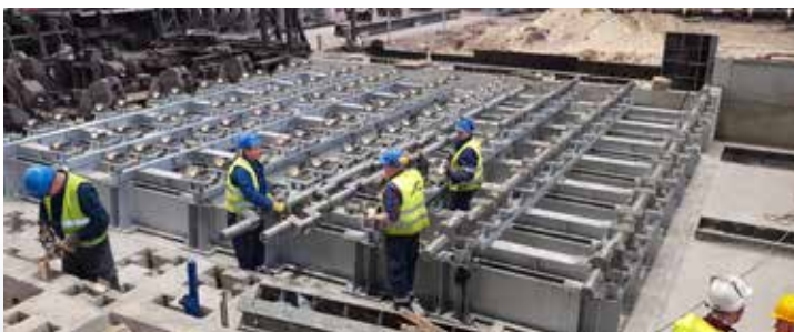
Construction de ligne de refroidissement de barres d'acier – HSJ Stalowa Wola
